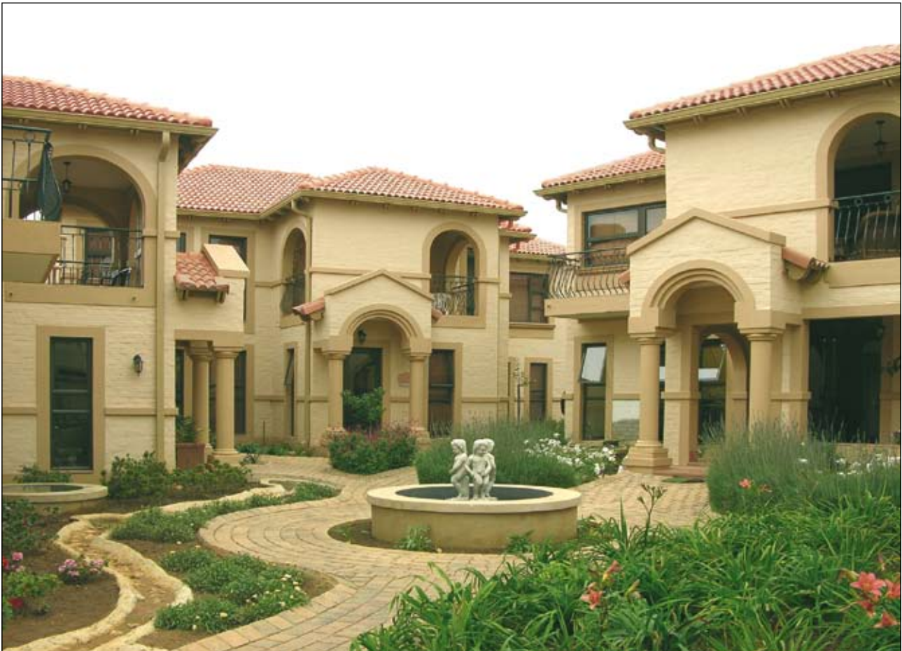
IL Villagio, Office Park, Gauteng
